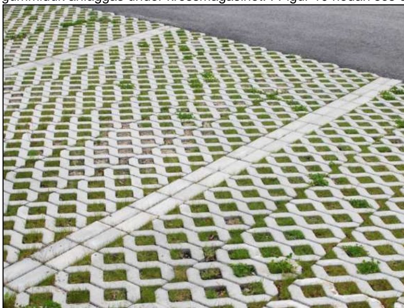
Figur 10. Rasteryta med gräs anlagd på parkeringsplats (Foto Bjerking AB).
