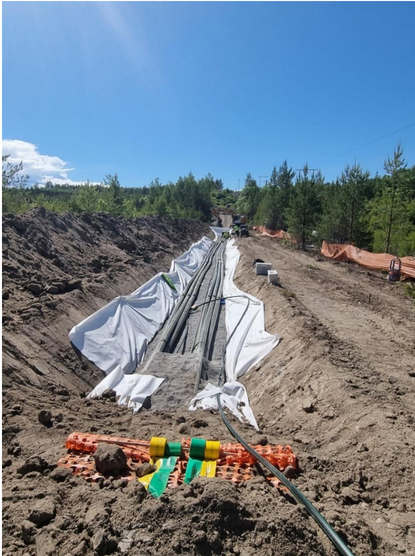
Figur 18. Foto över kabelschakt med två parallella kabelförband enligt vad som planeras för kabelsträckan för aktuellt projekt.
