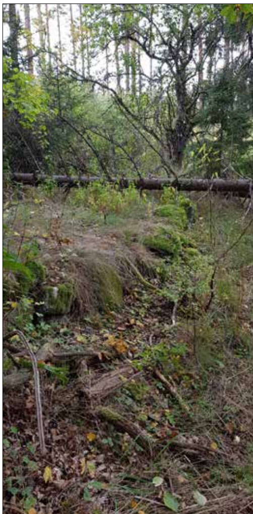
Figur 12. Terrassering vid husgrunden för torpet Rosenborg under Billby. Lämningen är kraftigt övervuxen. Foto från nordväst.
