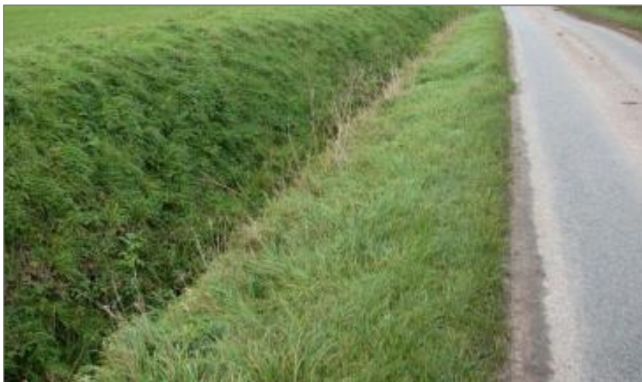
Figur 6-6. Exempelbild av ett gräsdike vid en väggkant.
