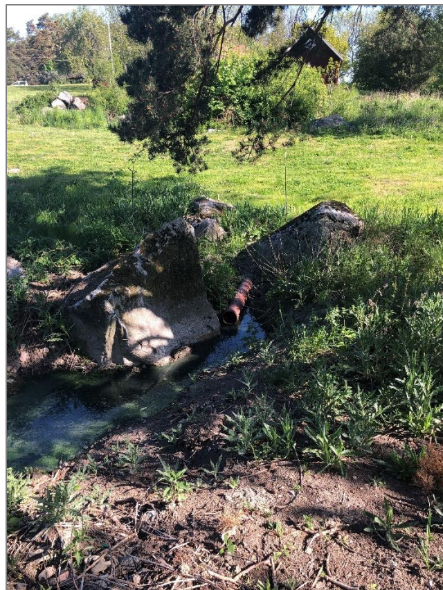
Figur 7. Ett dagvattensystem som avleder vattnet från villorna söderut mot dike vid Gredelbyleden.
