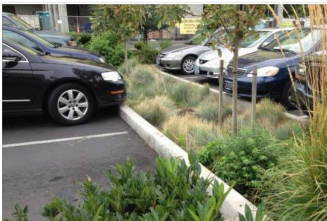
Figur 6-3. Exempel på en nedsänkt regnbädd intill en parkering (Vegtech, 2017).
