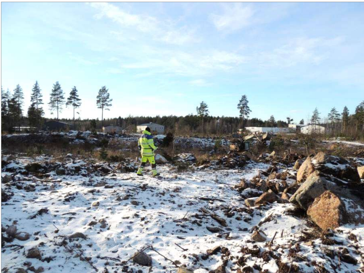
Figur 15. Robin Lucas inventerar skador efter röjningsarbete vid Objekt 16. Foto mot Ö.
