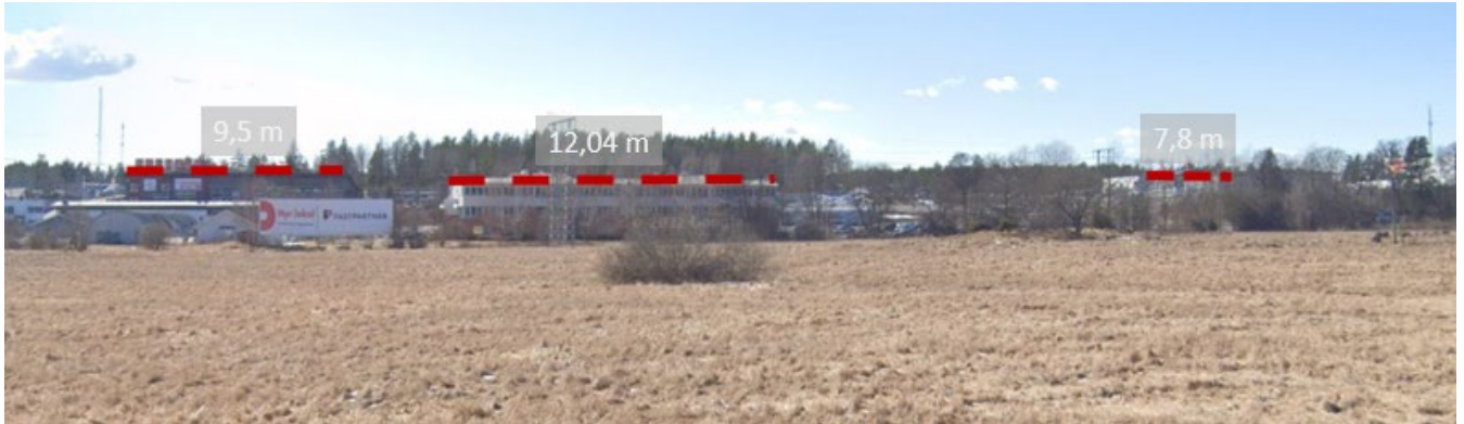
Bild 5 Fotot visar planområdets bebyggelse sett från E4:an. I bilden syns byggnadernas nockhöjd enligt det beviljade bygglovets för att få en uppfattning om den skala som finns på platsen.
