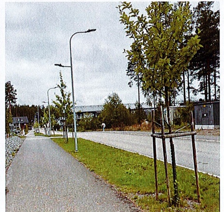
Referens grönremsa med svackdike, träd och belysning
